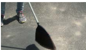
①シート設置面の清掃
