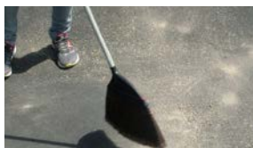
①シート設置面の清掃
